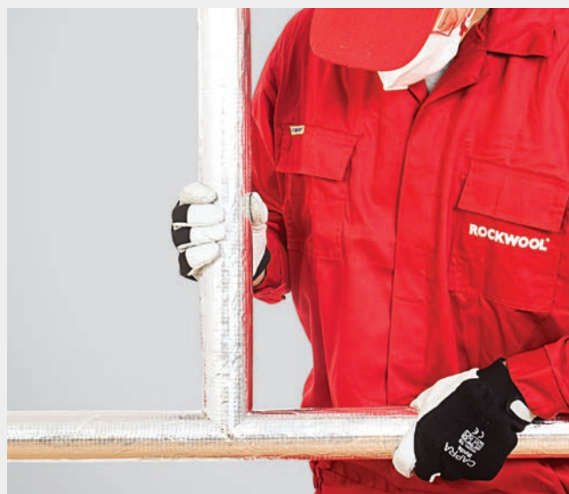
Dopasowanie łączonych odcinków.
