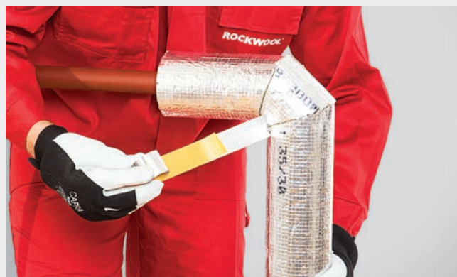
Sklejenie połączeń poprzecznych taśmą aluminiową.
