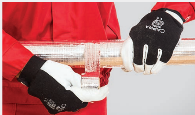
Zabezpieczenie połączenia poprzecznego otulin samoprzylepną taśmą aluminiową.
