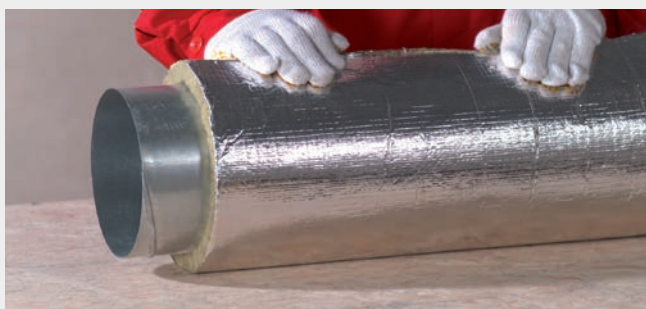
Krok 2 – owinięcie kanału izolacją.
