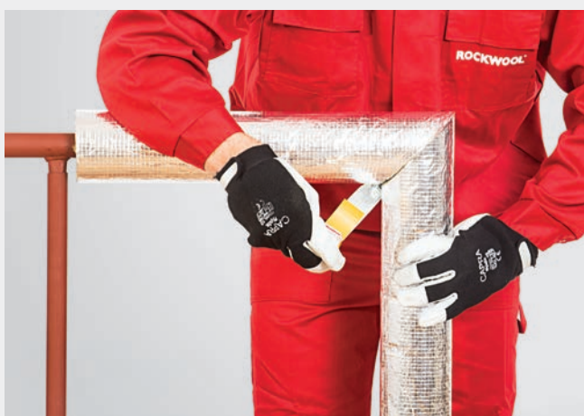
Zabezpieczenie połączenia poprzecznego otulin samoprzylepną taśmą aluminiową.
