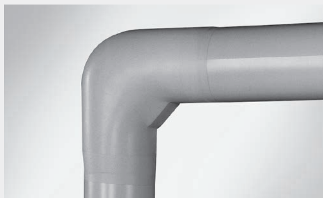
Nażenie osłony PVC na zaizolowane kolano, ze sklejeniem wszystkich połączeń taśmą PVC.
