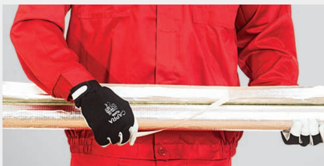
Ściągnięcie taśmy PE z zakładki samoprzylepnej.
