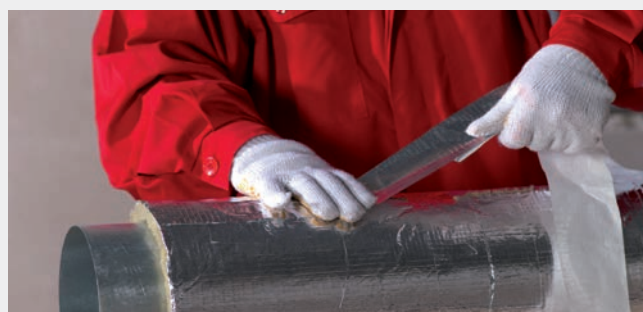
Krok 3 – uszczelnienie taśmą aluminiową połączeń podłużnych i poprzecznych.
