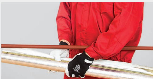
Nałożenie otuliny na odcinek prosty rurociągu.
