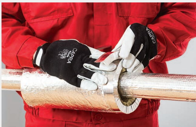
Zabezpieczenie zakończenia izolacji mankietem aluminiowym.
