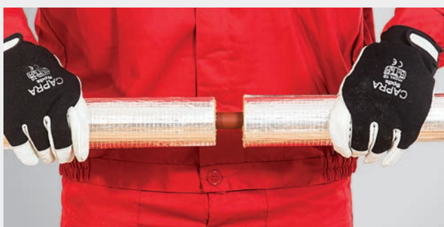
Połączenie poprzeczne dwóch odcinków otuliny.
