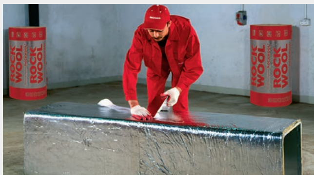
Krok 4 – uszczelnienie taśmą aluminiową połączeń podłużnych i poprzecznych maty.
