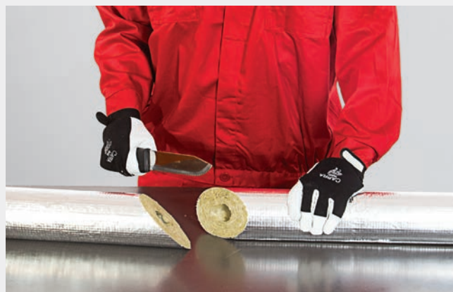
Rozcięcie otuliny pod kątem 45° na dwa elementy.
