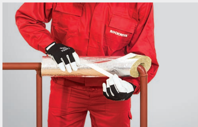
Sklejenie połączenia wzdłużnego zakładką samoprzylepną.
